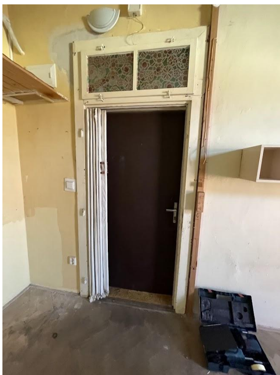
Obrázek č.1 – zdvojené vstupní dveře s nadsvětlíkem
