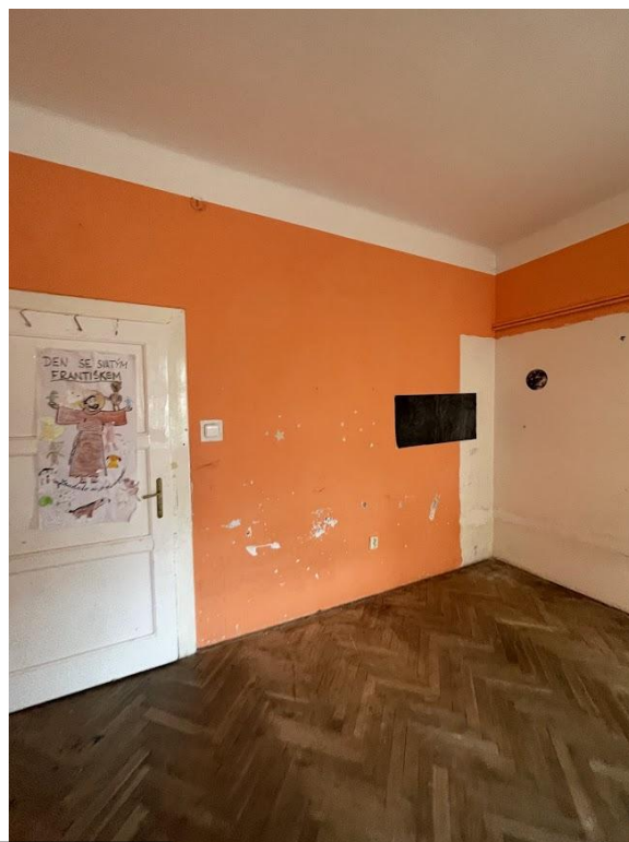
Obrázek č.5 a 6 – díry v omítkách k zapravení
